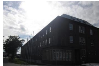
Das Landratsamt in Stralsund
