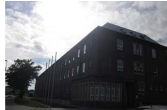
Das Landratsamt in Stralsund
