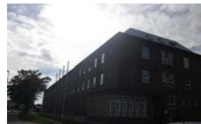
Das Landratsamt in Stralsund
