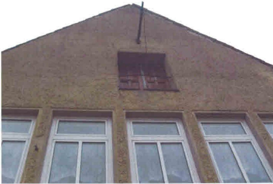
An der Giebelseite der Neuen Schule ist ein Flaschenzug zum Heben von Lasten auf den Dachboden angebracht.
